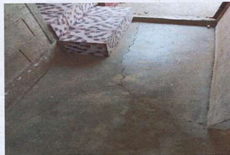
Foto 4: Sustitución de piso con fisuras por piso cerámico en el aula No. 2 y sustitución de piso con grietas por piso de granito en el área de la cocina y la bodega
