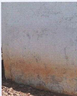
Reparación de repello en paredes interiores de aula 1, aula 2, cocina y bodega
