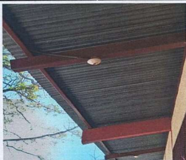
Foto1: Instalación del sistema eléctrico con cables, apagadores, plafoneras, bombillas led en aula 1 y 2, cocina, bodega y baños
