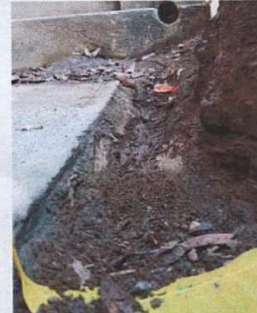
Foto 2: Reparación de cuneta de concreto con cemento gris
